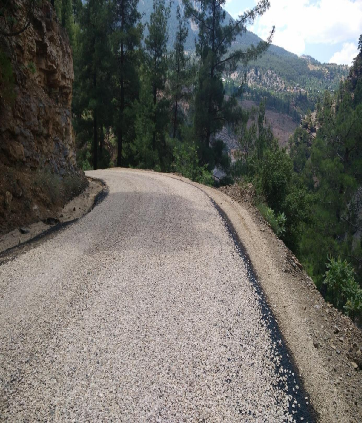
Daran Koçaşlı Köy Yolu Asfalt Yapımı
